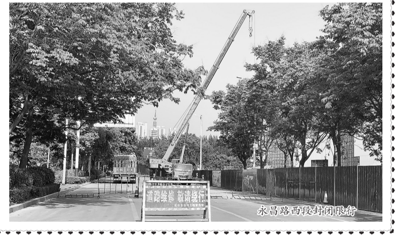
永昌路西段封闭限行
