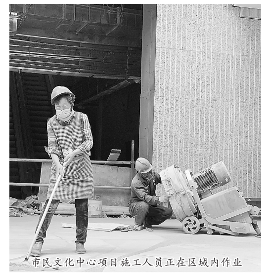
市民文化中心项目施工人员在区域内作业
